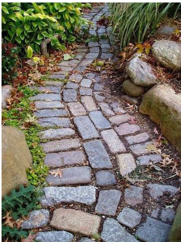
Vízáteresztő burkolat helyi építőanyagok felhasználásával
