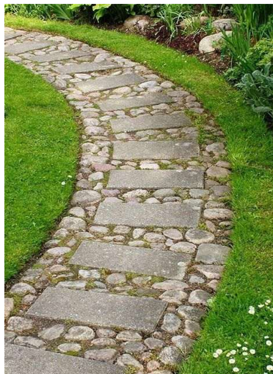
Vízáteresztő burkolat helyi építőanyagok felhasználásával
